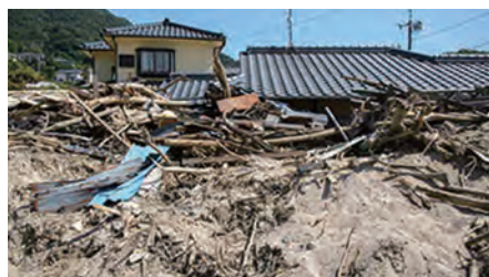
大量の土砂による住宅被害(西日本豪雨)
