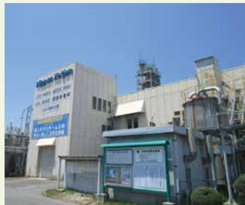
日本キッチン 工場外観
