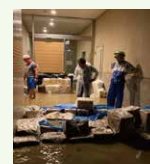
エントランス付近の開閉部 (手作りの土嚢で浸水を阻止)
