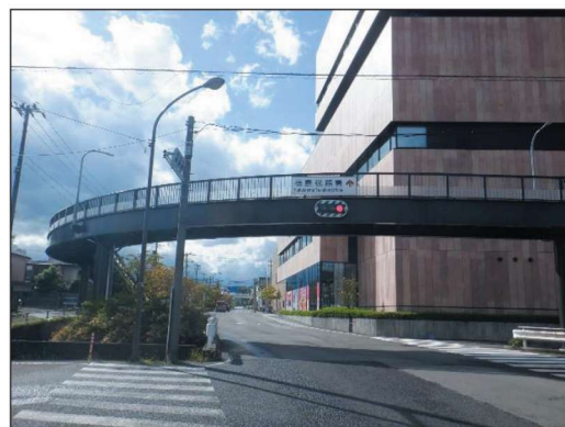
〈外観(東側)〉 国道13号線と国道4号線をつなぐ主要道路に架かる歩道橋です。
